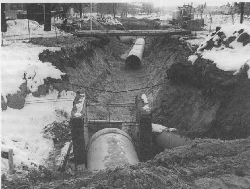
Уникальная возможность проведения монтажных работ – быстрота и легкость монтажа, отсутствие необходимости сваривания труб
