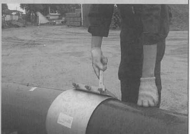
**2** Постепенно закрутите гайки, тем самым обеспечив плотное прилегание резиновой поверхности хомута к трубе.
